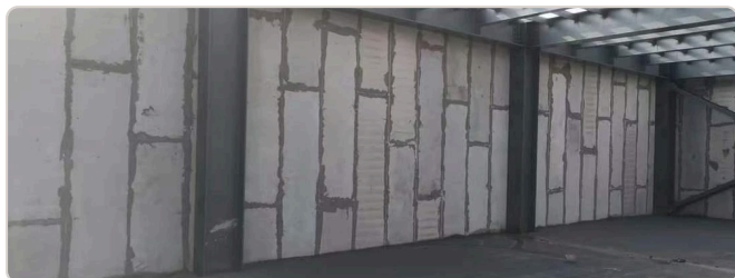
Particiones interiores en nave industrial
