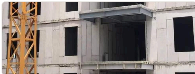
Cerramiento exterior en edificio en construcción
