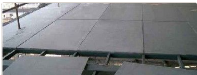
Suelo técnico instalado sobre estructura metálica en obra — panel levantado mostrando la malla de apoyo
