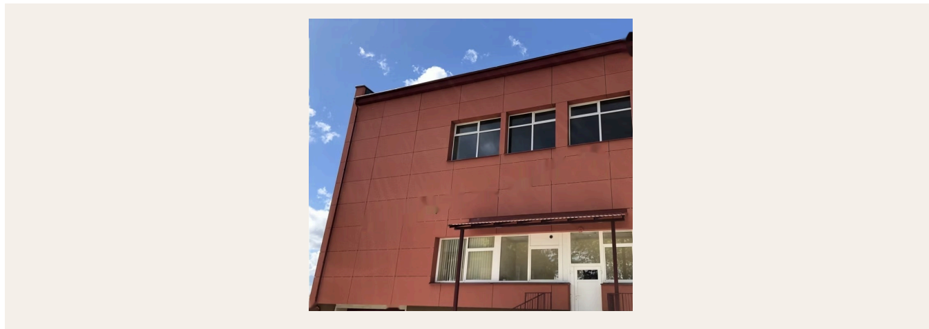
Fachada ventilada de nave industrial — acabado terracota, cantos rectos de fábrica.
